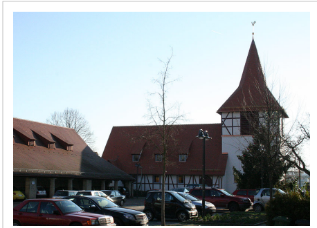
Michaelskirche (rechts) und Hochbunker (links) in Stuttgart-Neuwirtshaus
